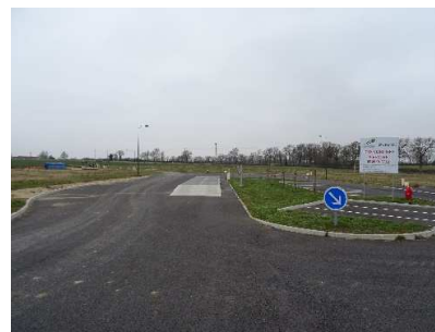
Lathus-Saint-Rémy - Zone d'activité Les Patureaux : Distinction des espaces poids lourds et voitures, mais absence de signalétique piétonne et cheminements doux
